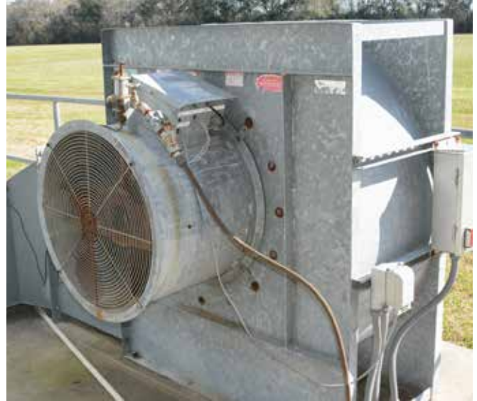
Fig 8-2. Centrifugal fan.
